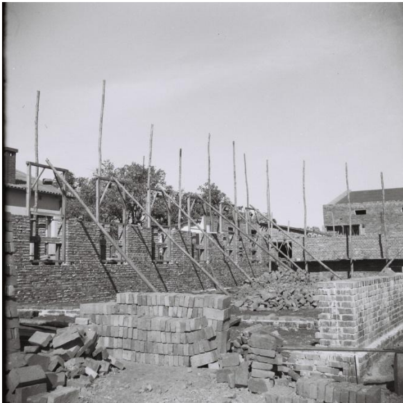
Fig. 9. Sakristian och kyrkväggar byggs upp.
