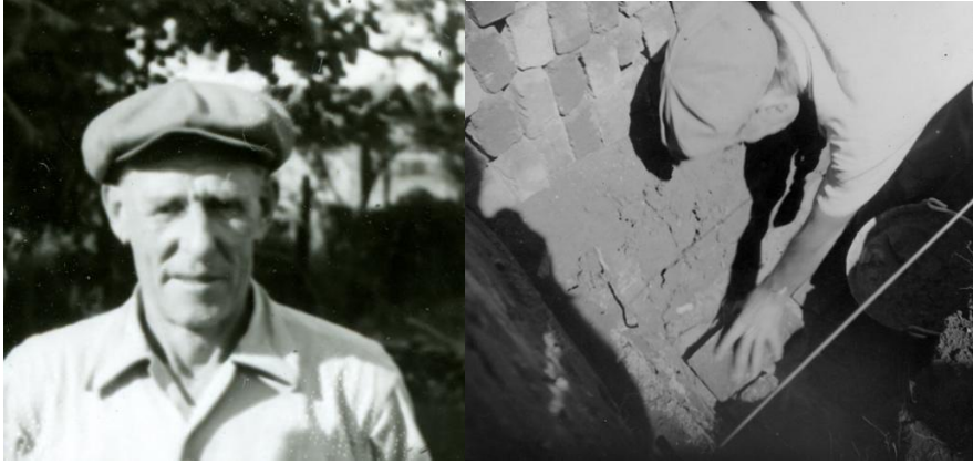
Fig. 2. Bygglédaren Paul Bergman. Fig. 3. Paul lägger grunden till kyrkan
